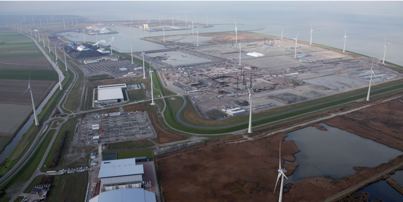
Bovenstaande luchtfoto laat duidelijk de mega-activiteiten zien die momenteel in uitvoering zijn voor de realisatie van de diverse energiecentrales. Ook Nuon is nu volop aan het bouwen.
