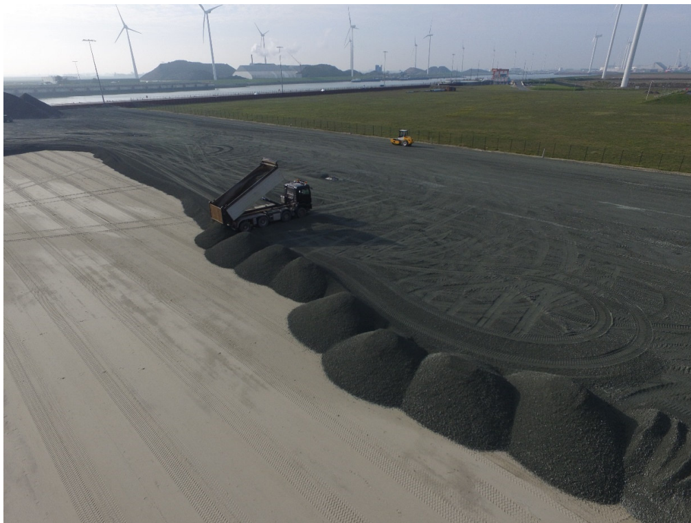
Figuur 4: De inrichting van de BOW terminal in volle gang
