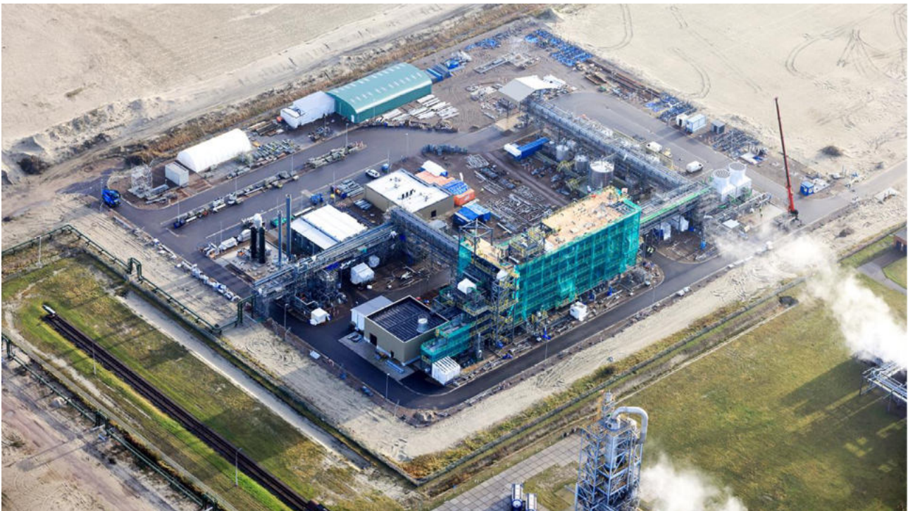
Avantium in aanbouw
