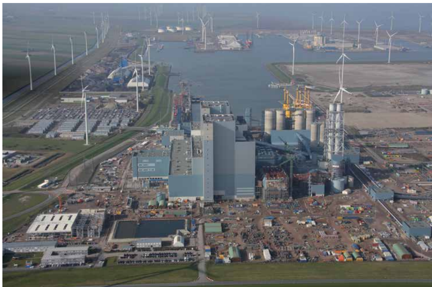
De Eemshaven met op de voorgrond de in aanbouw zijnde kolencentrale van RWE
