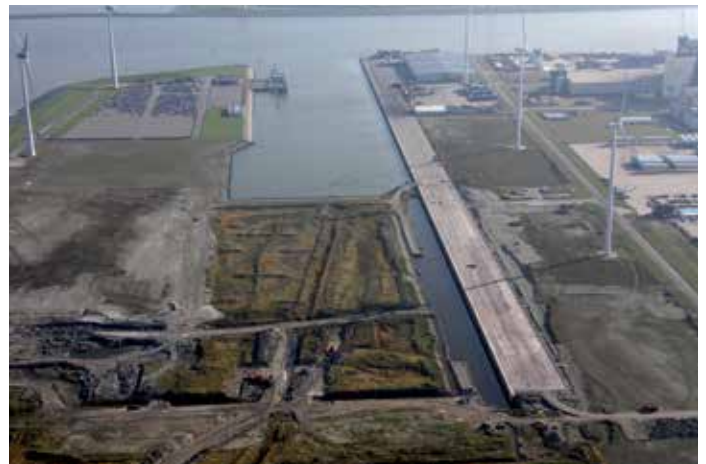
De werkzaamheden van de verlenging van de zuidkade van de Beatrixhaven met bijna 500 meter zijn nagenoeg afgerond
