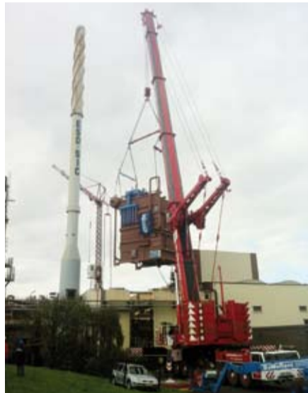
Op de foto is te zien hoe de nieuwe ketel op zijn plaats wordt getakeld
