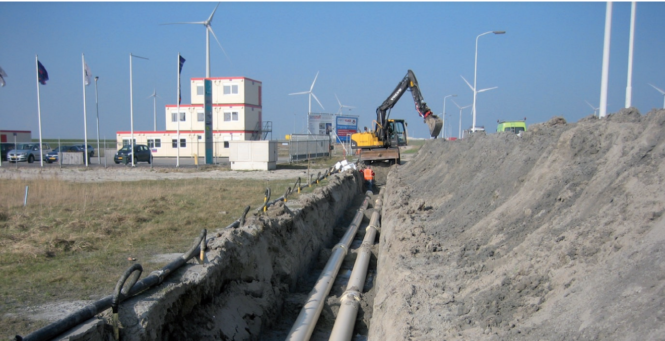
North Water lift mee bij de aanleg van de rioolleiding door Groningen Seaports
