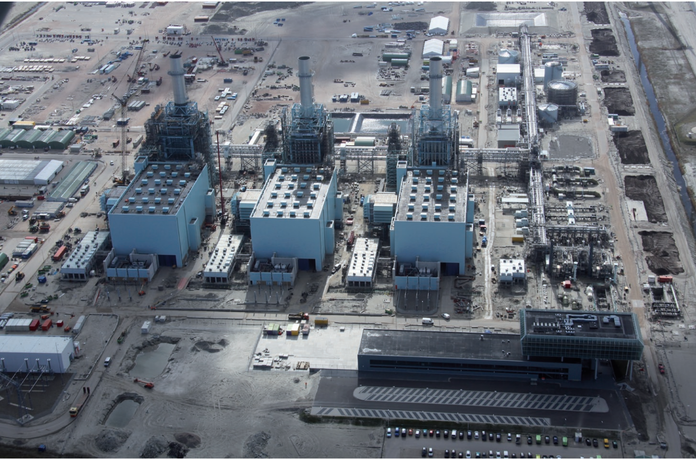
De Nuon Magnum centrale met op de voorgrond het kantoorgebouw
