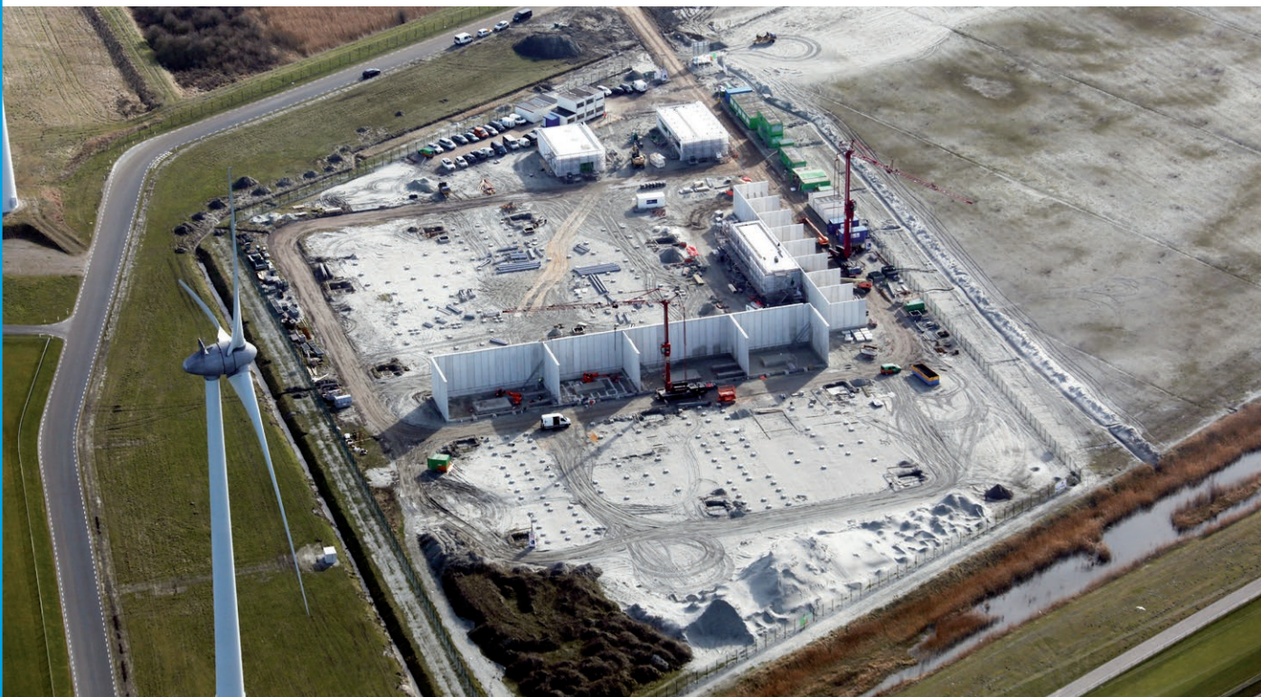
De bouw van het transformatorstation is in volle gang.
