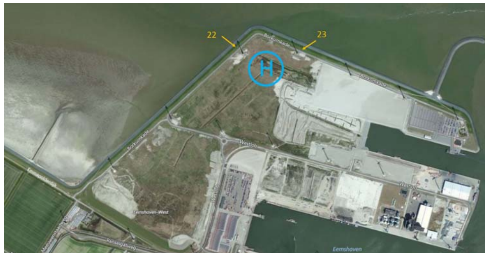
Figuur 1 De beoogde locatie voor de helikopter start- en landingsplaats (H) en nabij zijnde windturbines (22 en 23). Bron locatie: AdecS Airinfra, 2015. Bron luchtfoto: Bing Maps.
