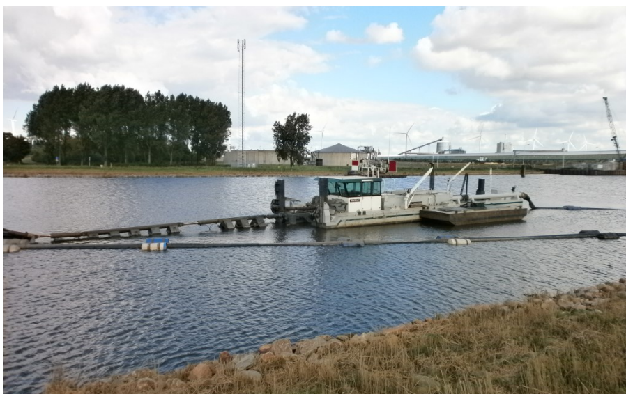
Figuur 5: Baggerwerken in de Oosterhornhaven 2015/2016
