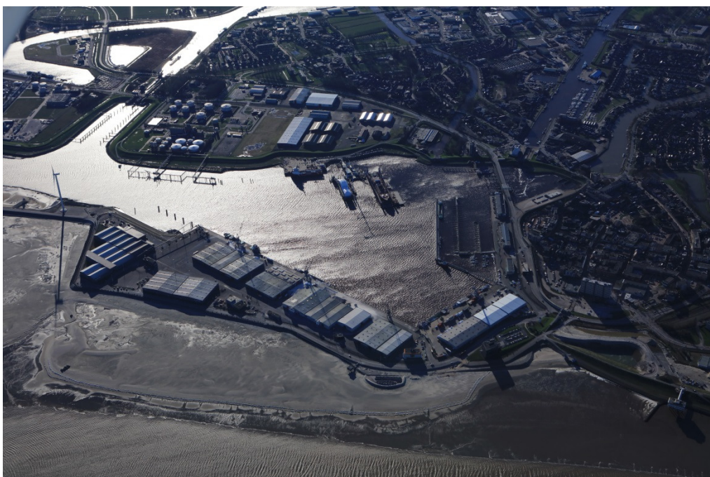
Figuur 4: De vernieuwde Drijvende Steiger in de Handelshaven van Delfzijl
