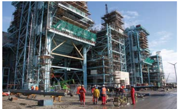
De bouw aan de energiecentrales zorgt voor veel werkgelegenheid, zoals hier te zien is bij de Nuon centrale
