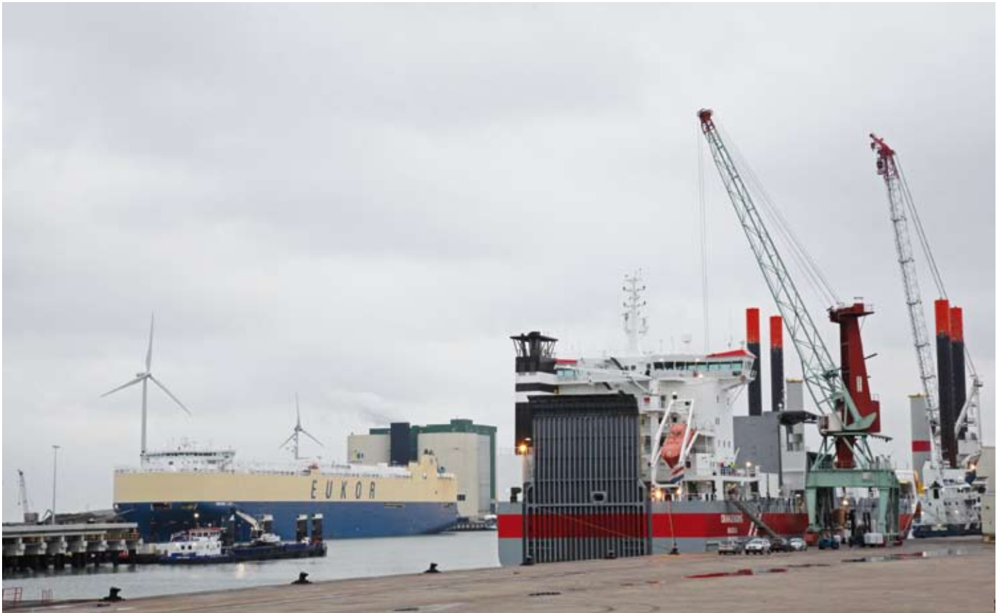
Drukte in de Julianahaven met onder andere de bouwactiviteiten aan de oliesteiger, het grote roroschip Morning Lady en de Oranjeborg
