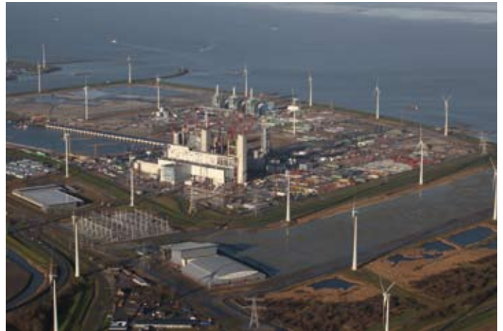
Het Energy Park Eemshaven met Norned op de voorgrond en de centrales van RWE/ Essent en Nuon/Vattenfall in aanbouw op de achtergrond
