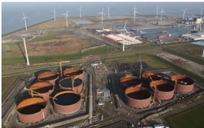
Vopak Terminal Eemshaven in aanbouw
