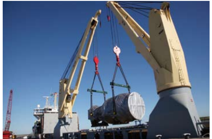
Zwaar transport in de Beatrixhaven waar een transformator, afkomstig uit Japan, wordt gelost ten behoeve van de in aanbouw zijnde Nuon Magnum energiecentrale
