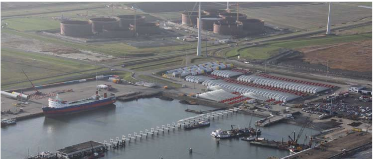
In de Julianahaven wordt hard gewerkt aan de aanleg van oliesteiger voor de tankers van Vopak. Op de achtergrond de in aanbouw zijnde opslagtanks
