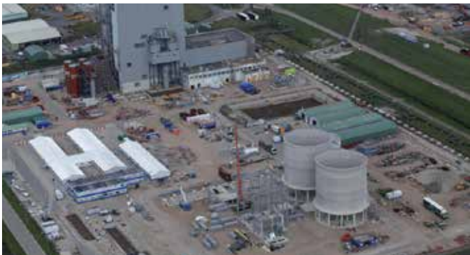
De biomassacentrale van Eneco Bio Golden Raand in aanbouw
