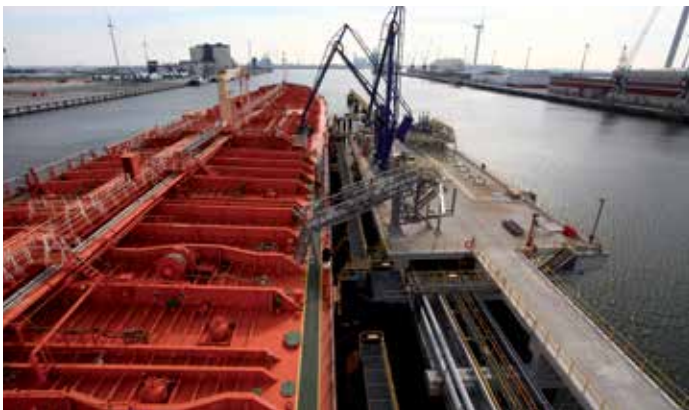
MS Eagle Matsuyama was het eerste olieschip dat afmeerde aan de nieuwe oliesteiger in de Julianahaven
